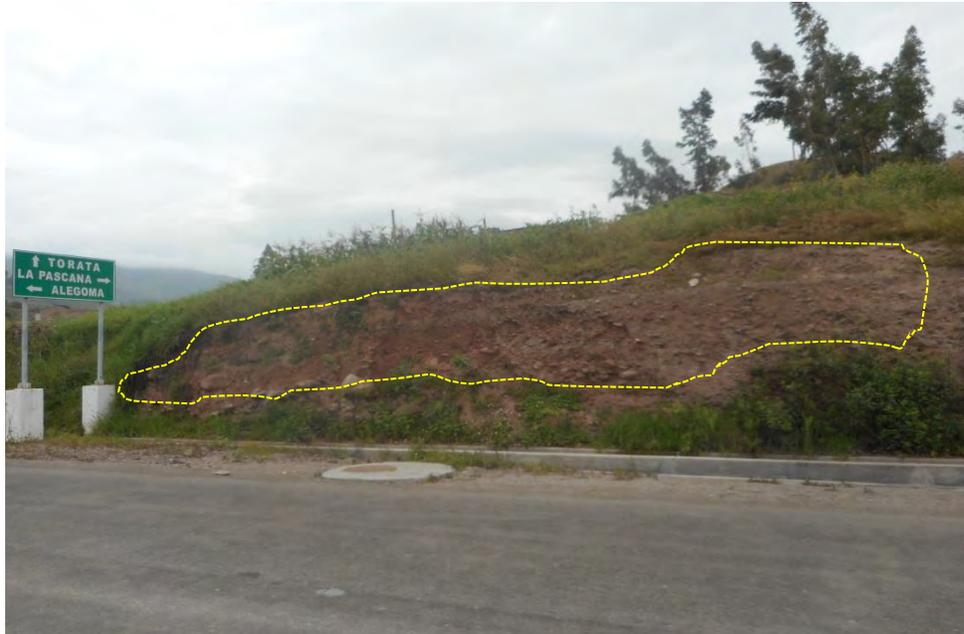
Nota. Con presencia de gravas con redondez y esfericidad angulares y subangulares, de 3” de diámetro, en una matriz arcillosa rojiza, de mediana plasticidad, en la parte superior e inferior presenta limos de color beige (línea amarilla). Ubicado a 1km al sur-oeste de Torata
