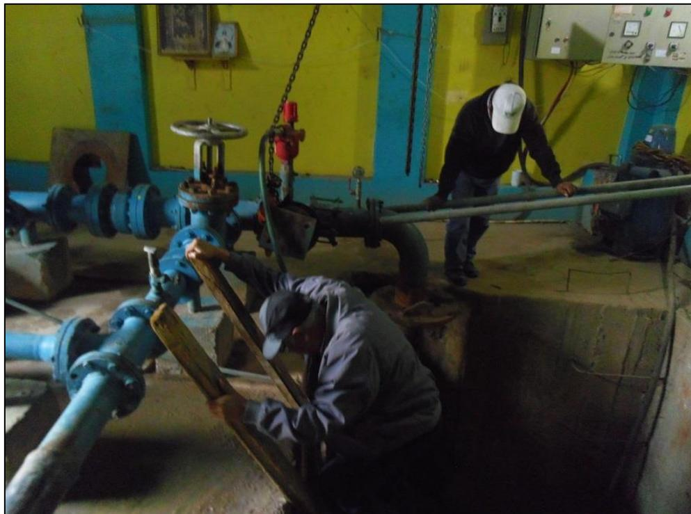
En la fotografía se observa al operador descendiendo hasta la base del pozo tubular para tomar las medidas de nivel estático, y posteriormente el descenso progresivo de los niveles dinámicos
