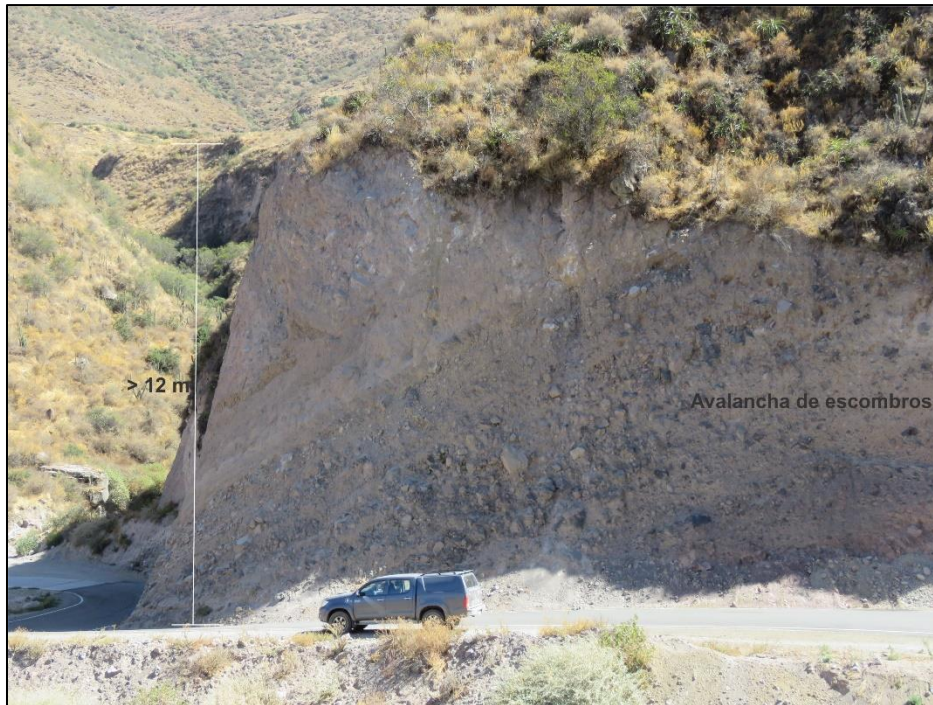
Foto 4.8 Afloramiento donde se ve un corte del depósito de avalancha de escombros con una potencia de más de 12 m, ubicado al costado derecho de la carretera Incuyo - Pausa.
