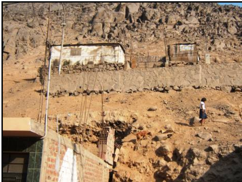
Foto N° 7. 14 AAHH Santa Rosa de Lima. Sector propenso a caída de bloques rocosos que se desprenden de un afloramiento meteorizado y diaclasado. Se observa un muro de contención que resulta insuficiente ante un desastre.
