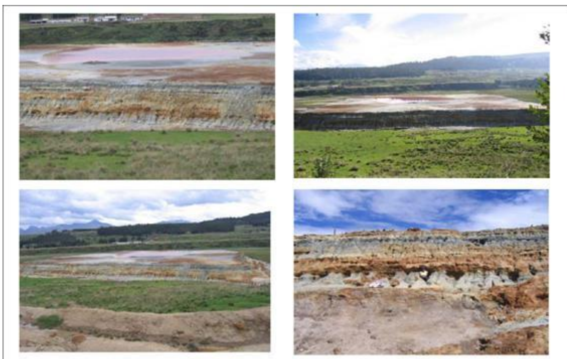
Figura 3.6. En la parte superior se aprecian las grietas de desecación en forma de mosaico donde la separación entre las grietas está rellenas de los productos de meteorización debido a los procesos geoquímicas a que están sometidos los residuos en las balsas. En la parte inferior diferentes imágenes del depósito y la erosión en cárcavas visible en sus taludes.
