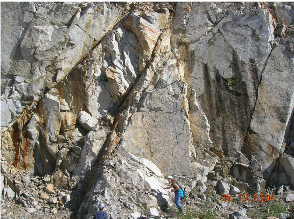
Figura 8.1. Zona del talud 3E con mayor riesgo obtenido a partir de ROFRAQ
