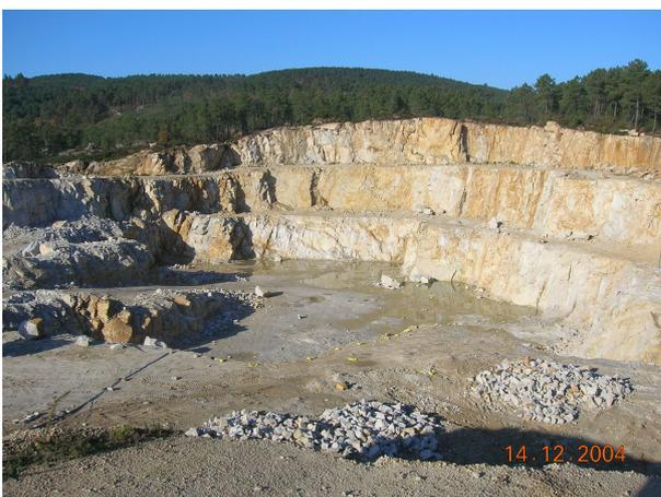
**Foto 4.3** Vista de los tres bancos de la cantera, nótese que el banco de mayor cota pierde altura hacia la parte izquierda hasta desaparecer.
