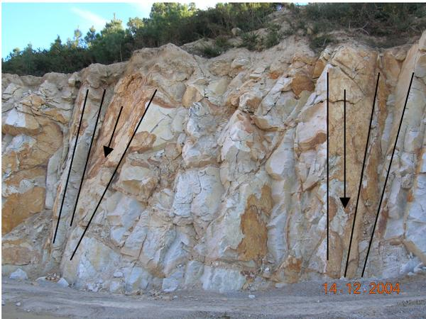
Figura 6.11. nótese la zona derecha e izquierda en particular, en ellas se puede apreciar la formación de cuñas.
