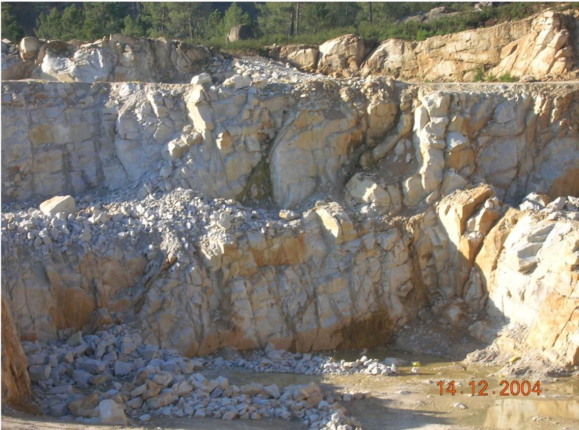
Figura 8.2. Talud 3E mostrando el mecanismo de rotura por vuelco
