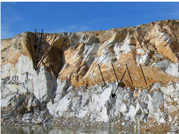
Figura 6.5. Se puede apreciar en la zona media de la fotografía la roca que puede fallar por vuelco mientras que en la zona izquierda, en la parte superior se ven las cuñas que se forman.
