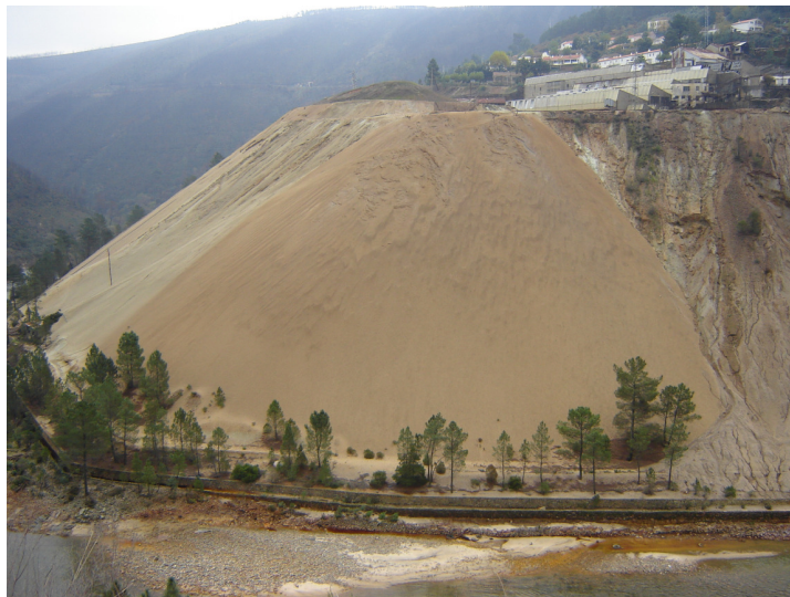
Figura 20: Lixiviados en presa de residuos mineros, unidad minera Panasqueira
