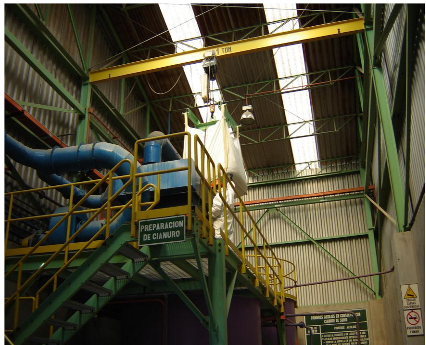
Fotografía IV: Operador verificando el ingreso del cianuro embolsado para su preparación.
