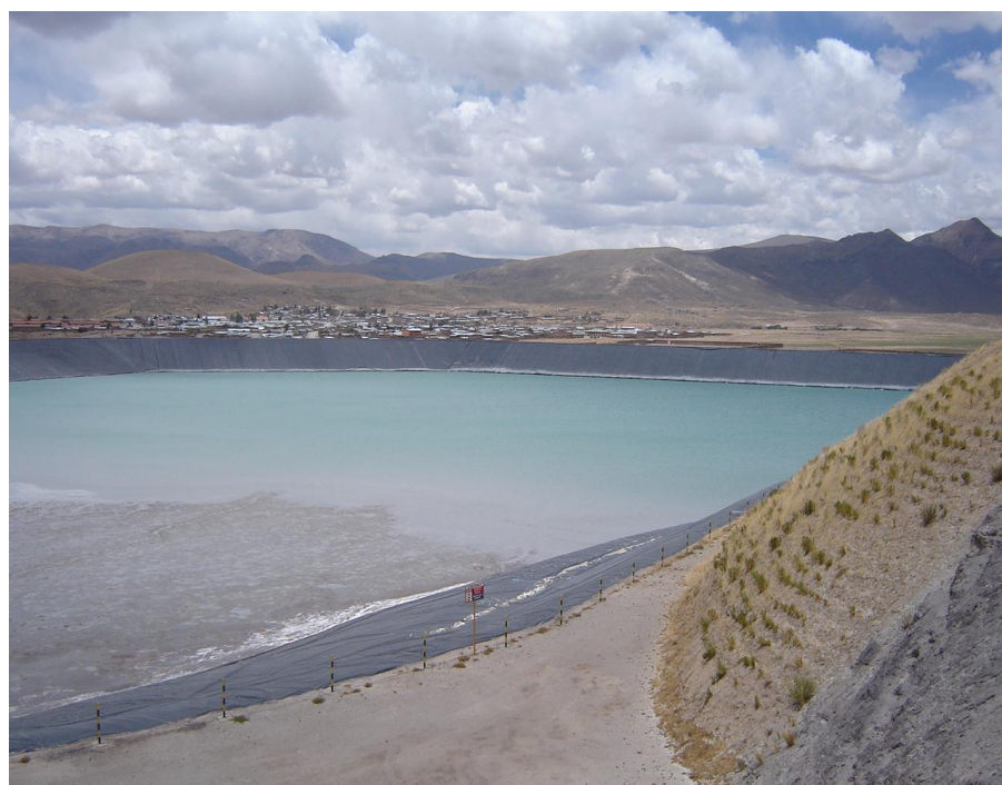
Fotografía N° IV: Presa de relaves 4 Mirando al NE del Extremo opuesto.
