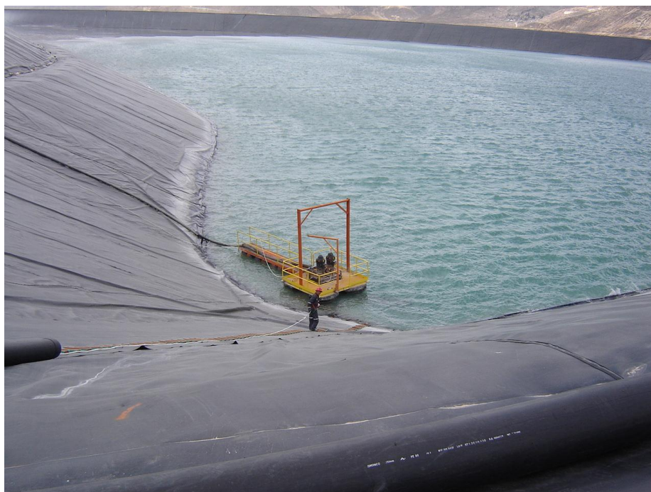
Fotografía N° XIII: Presa de relaves N° 4 mirando al NO.
