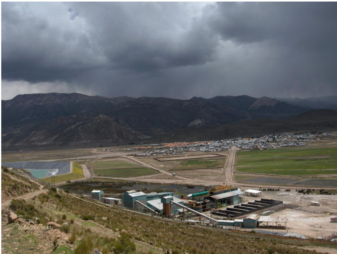
Fotografía N° 5: Planta de Procesos mirando al NE, pueblo de Orcopampa al fondo.
