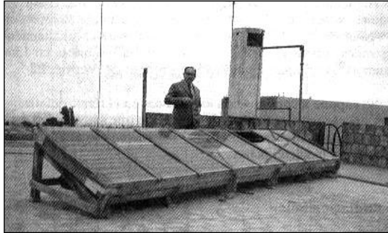
Figura – 1 Calentador solar de 250 litros construido por el Sr. Ernesto Barreda.
