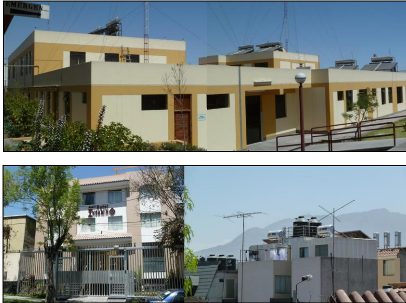
Figura - 6 Calentadores solares de agua en emergencia del hospital Goyoneche y en el sector hotelero de Arequipa.
