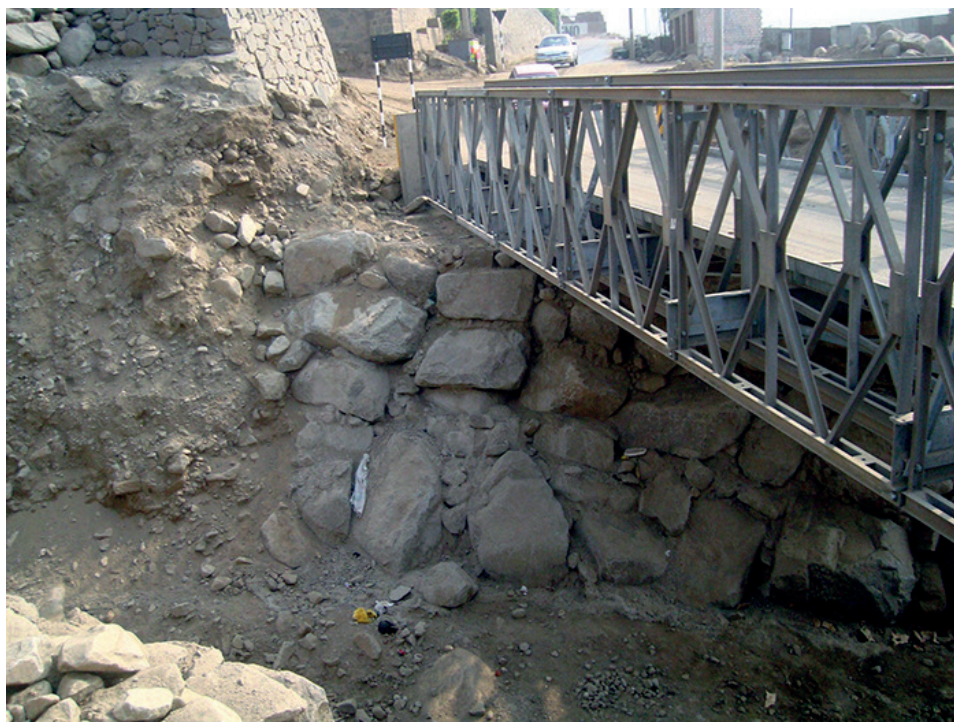
Figura 7. Puente para el paso de vehículos y personas en la parte baja de la quebrada (las bases son de rocas de gran diámetro). Fuente. Elaboración propia
