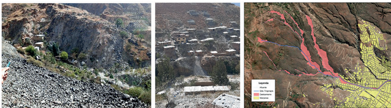
Figura 5. Deslizamiento de material removido 2019
