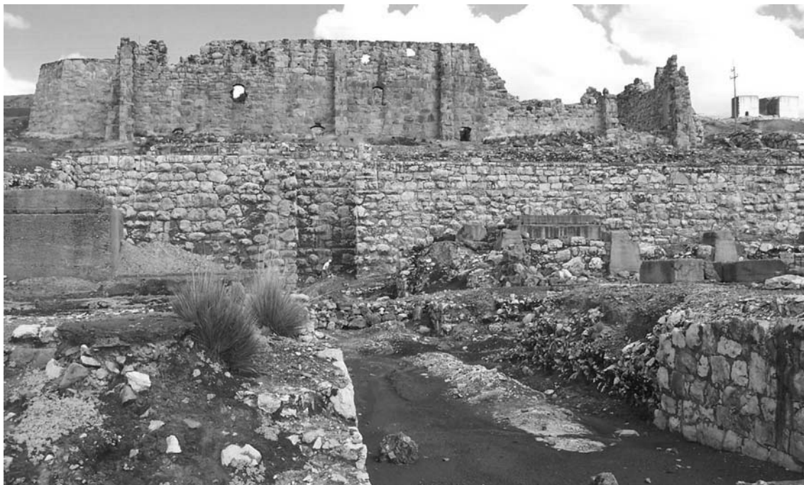
Foto 4. Nótese construcción pétreo constituida por roca volcánica, petrográficamente denominada toba.
