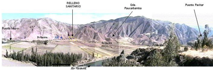
Foto N.º 1. Vista panorámica de la ubicación del área de relleno sanitario y configuración topográfica de las zonas de influencia.
