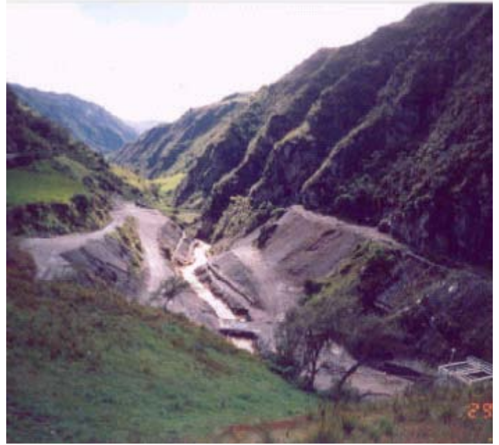
Desmontes en la quebrada Tingo (Fotos FONAM 2005)
