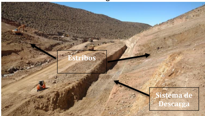
Fotografía 01: Excavaciones en estribos y sistema de descarga
