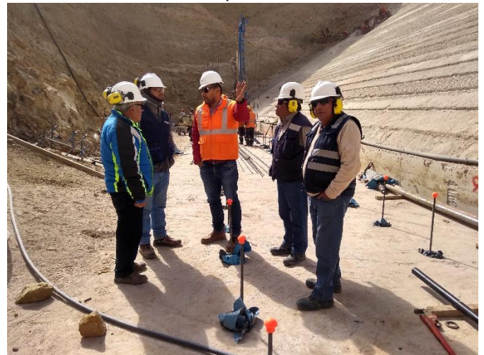
Fotografía 03: Supervisión de ejecución de micropilotes
