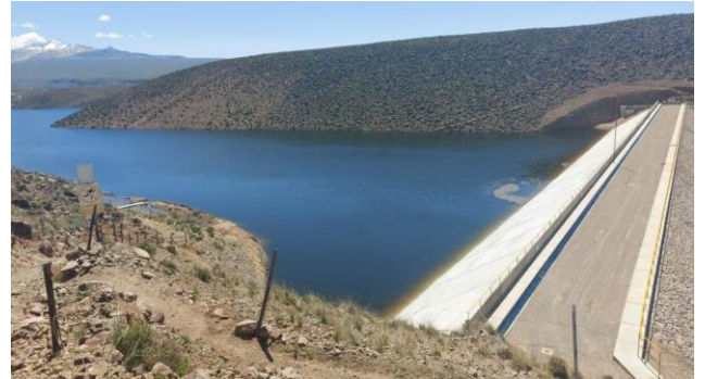
Fotografía 04: Presa Cularjahuira en proceso de llenado
