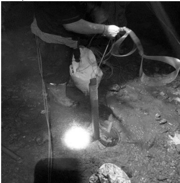
**Fig.17** Diseño de carguío utilizando tubería de PVC en carga desacoplada, la cual cada taladro tiene un diámetro de 64 mm, sin embargo, solo se cargaban 40mm (véase fig. 11), lo que disminuyó en un 37% la cantidad de explosivo cargado por tonelada. Con esta técnica se pudieron explotar paneles de mineral con ancho de veta de <0.8 mts para cajas regulares a malas de acuerdo con la clasificación de RMR.
