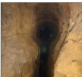
Fotografía de tajo antes y después del relleno
