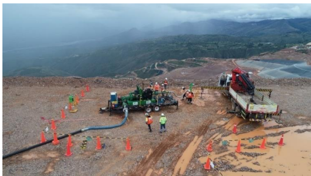
Figura 14. Máquina de inyección en el pad 1A al costado del pozo donde se inyectará a presión la solución cianurada con la lechada de cal.
