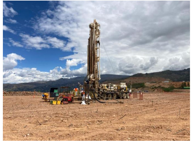
Figura 10. Se muestra la perforadora SCHRAAM T-130 trabajando en el pad 1A.
