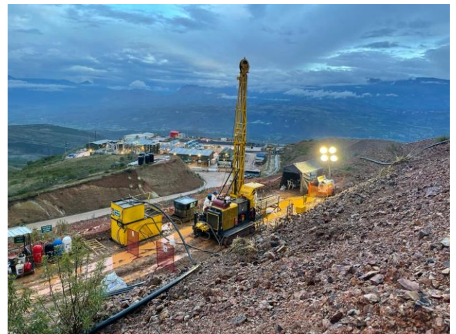
Figura 13. Construcción de un piezómetro de monitoreo adicional utilizando la máquina de perforación diamantina CS-14.
