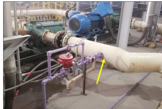
Fotografía 1. Inyección de CN Concentrado
