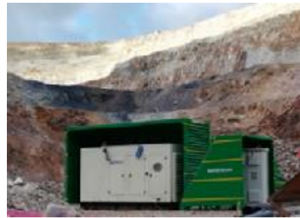
Gráfico N°5: Implementación de protectores en componentes superficiales del sistema de bombeo.
