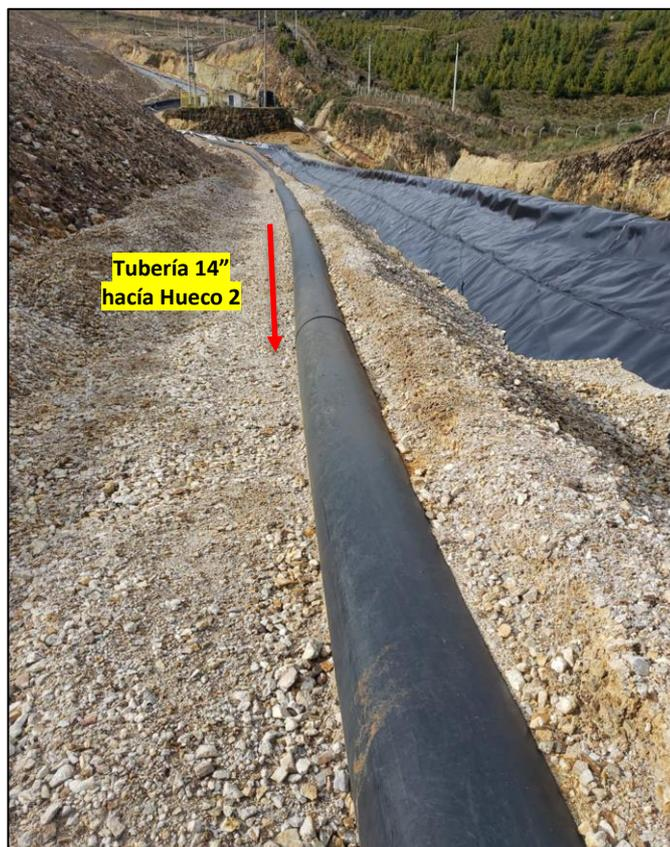
Foto 1: Línea HDPE 14” para descarga de celda dinámica
