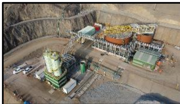
Fig.29. Planta de Relleno Hidráulico Cementado en construcción.
