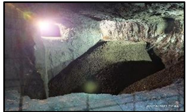
Fig.22. Deposición de Rock Fill en tajos.
