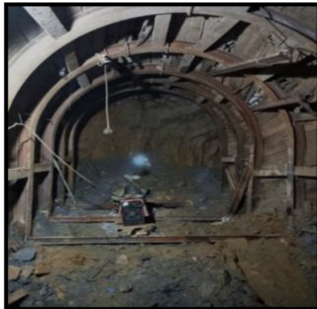
[Figura 11].- Instalación de la viga de acero del Arco Peruano en tajos de producción.
