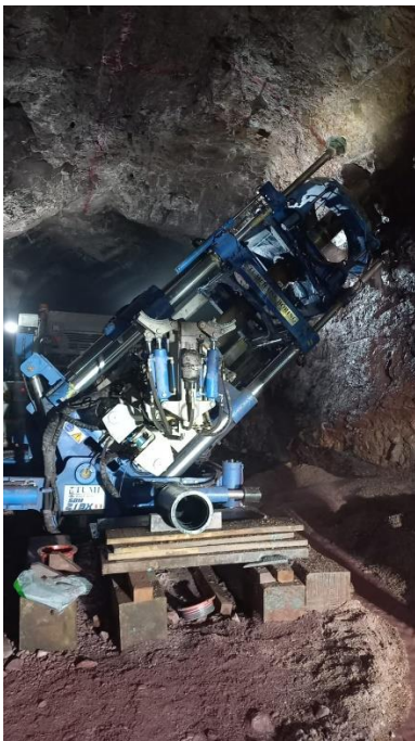
Fig. 28. Perforación del segundo proyecto.
