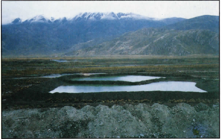
Poza de sedimentación de sólidos del agua de minas
