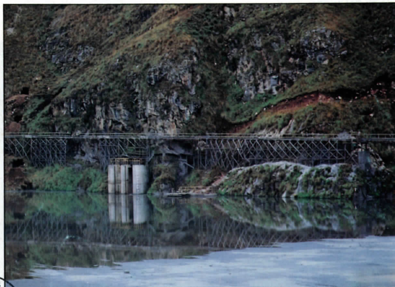
Sistema de captación de agua del depósito de relaves
