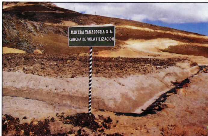
Cancha de volatilización de líquidos derivados del petróleo
