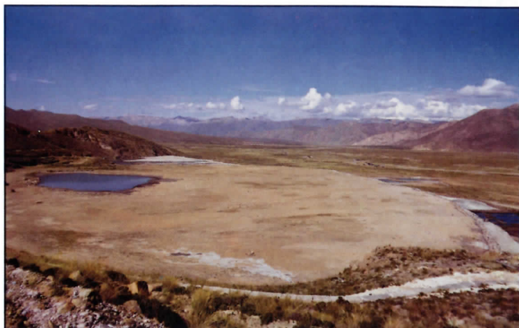
Presa de relaves N° 2 cubierta con tierra para su revegetación
