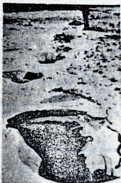
Fig. 7.— Pequeños cráteres formados al salir a presión el agua intersticial procedente de la arena licuada. Terremoto de Niigata, Japón (16-V-1964).
