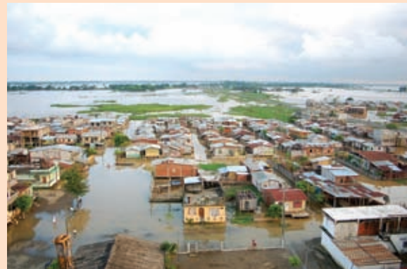
Foto 2: Viviendas inundadas en Babahoyo. Fuente: EMSABA.
