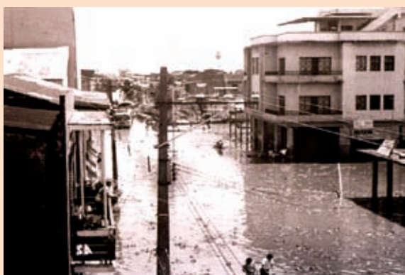
Foto 1: Vista de inundaciones en la ciudad de Babahoyo. Fuente: EMSABA.
