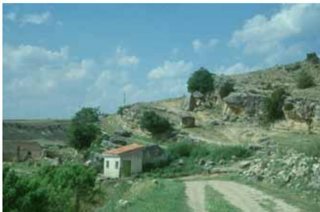
Figura 2. Captación de abastecimiento en Carboneras de Guadazaón (Cuenca) (foto: M. Martínez).
