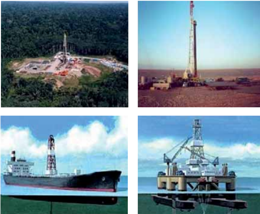
Figura 4. Operaciones de perforación en selva, desierto y mar.
