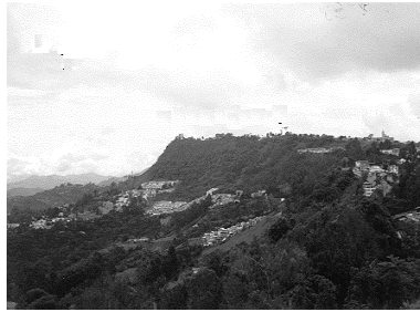
Escarpe de Falla. Ciudad de Manizales
