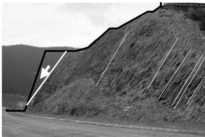
**Figura 8.8. Talud en un macizo rocoso de tipo flysch con discontinuidades bastante inclinadas. Estas discontinuidades no afectan la estabilidad el talud cuando sus rumbos no coinciden (derecha), pero han dado lugar a una inestabilidad para el caso de coincidencia de rumbo (izquierda). Foto: autores.**
