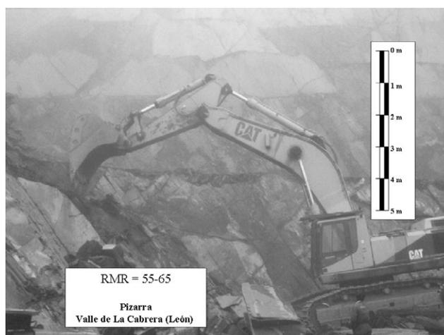
Figura 5.10. Macizo rocoso de calidad geotecnia media-buena. Fotografía: autores.
