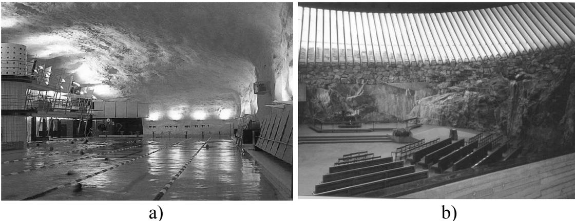
**Figura 1.15. Aplicaciones de la mecánica de rocas en ingeniería del espacio subterráneo urbano. a) Piscina subterránea sostenida con gunita blanca (Helsinki – Finlandia): foto tomada de Internet <http://www.mtry.org/images>. b) Iglesia subterránea en la ciudad de Helsinki. Foto: autores.**
