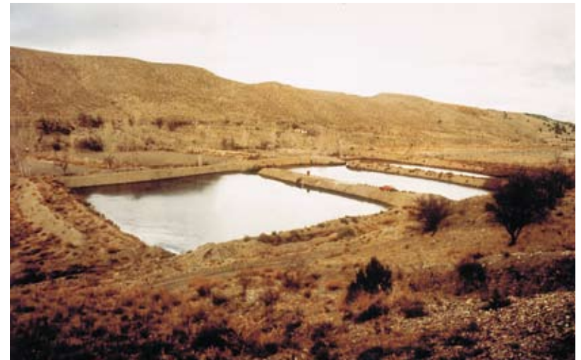
Recarga por balsas. En la imagen superior, esquema de dispositivo operativo; abajo, experiencia piloto en el aluvial de un río
