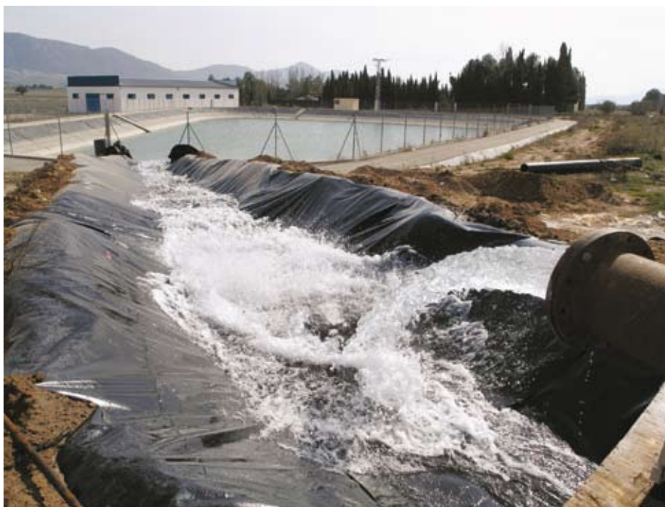
Regulación mediante un sondeo en Candela (Alicante)
