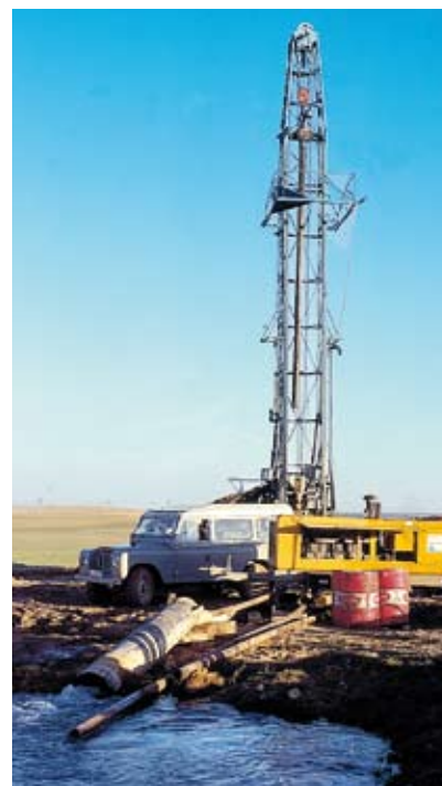
Perforación de un pozo por el sistema de rotación con circulación de lodos
