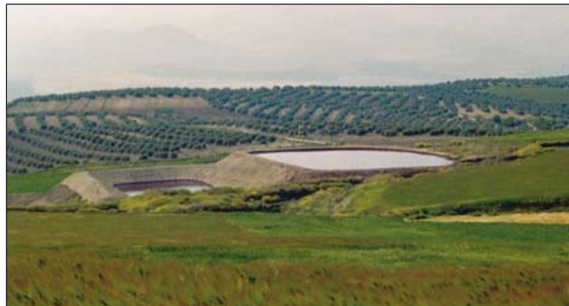
Eliminación de alpechines empleando balsas de evaporación situadas sobre formaciones geológicas impermeables. Éstas evitan la práctica habitual durante muchos años del vertido de estos residuos a los cauces superficiales y a los acuíferos
