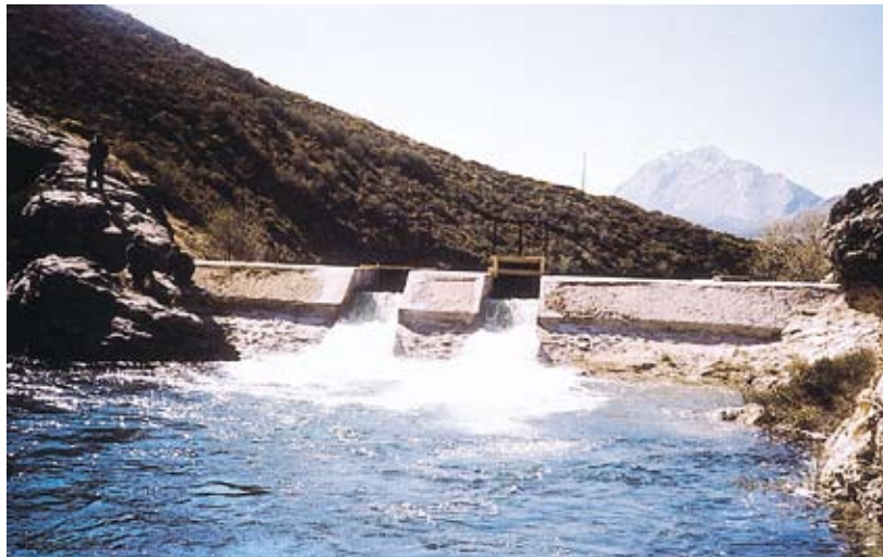
Recarga por represas. En la imagen superior, sistema de diques que retienen el agua, para posteriormente recargar el acuífero; abajo, experiencia piloto en el lecho de un río
