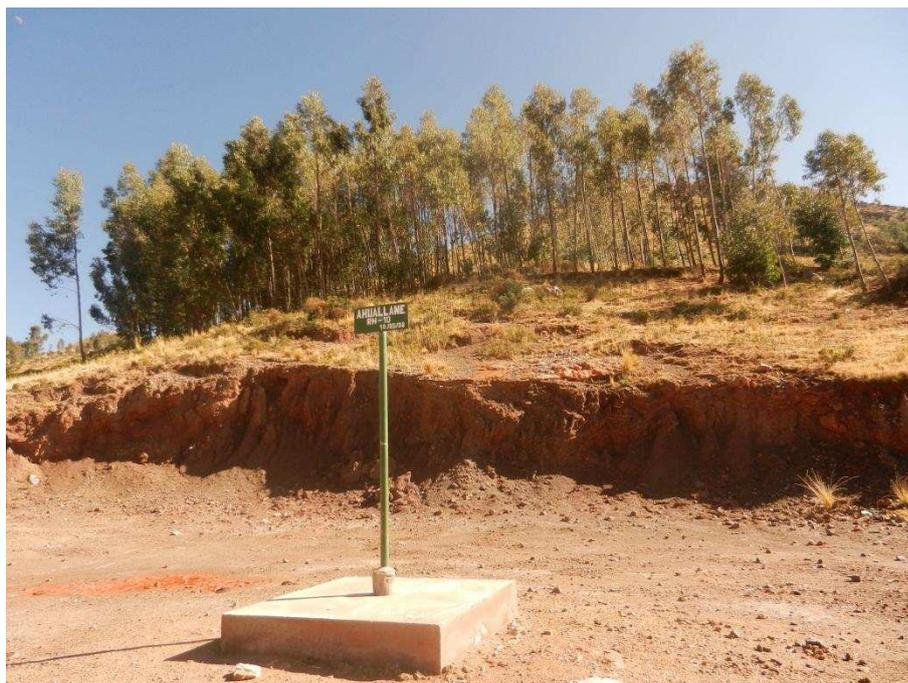
**Foto 44:** Pozo de extracción (RH-10) de crudo en el Campo Petrolífero de Pirin – Huancane, se encuentra cubierto por concreto de allí emanaba hasta hace 5 años atrás material de origen orgánico.
