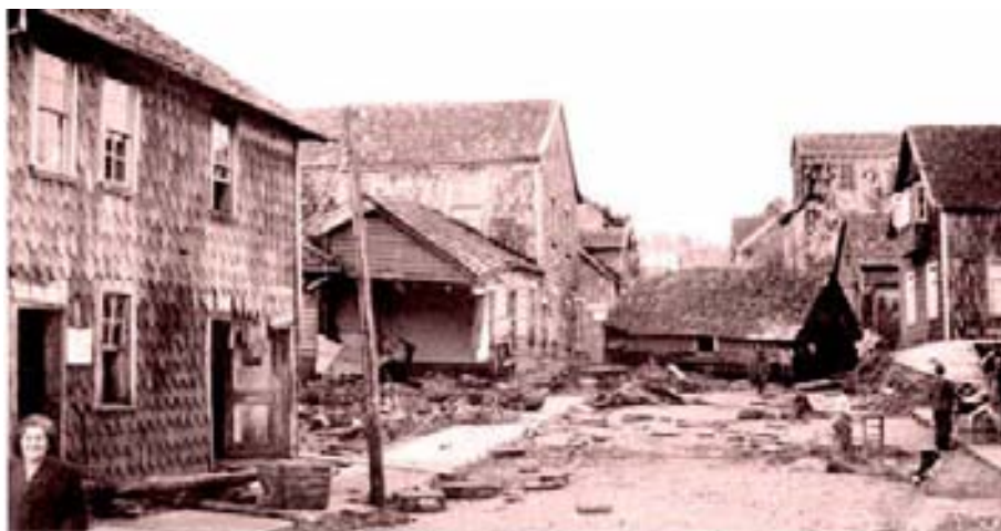
Figura 59. Efectos destructivos del tsunami en Maullín (Chiloé).
