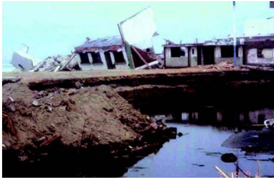
Figura 57. Efectos del tsunami del 23 de junio de 2001: destrucción de casas de veraneo al sur de Camaná, sector La Punta.
