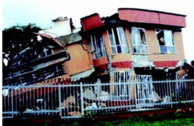
Figura 43. Destrucción de viviendas por el terremoto del 25 de enero de 1999.
