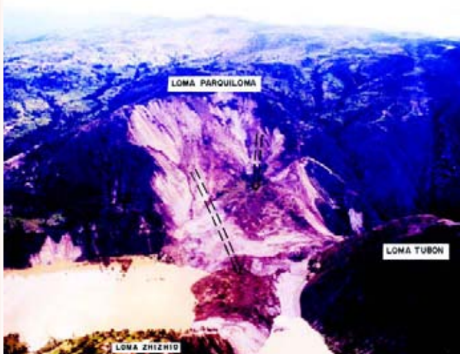
Figura 25. Vista de cerro Tamuga y talud actual del deslizamiento.
