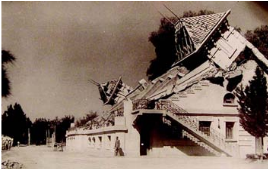
Figura 49. Daños en edificios de la ciudad de San Juan por efectos del terremoto de 1944.
