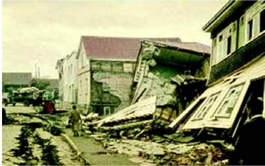
Figura 48. Daños en viviendas de Valdivia.
