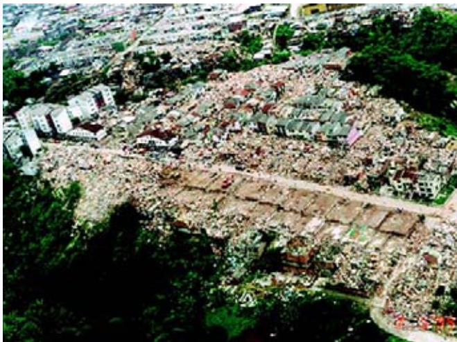
Figura 42. Vista aérea de la destrucción originada por el terremoto del 25 de enero de 1999.
