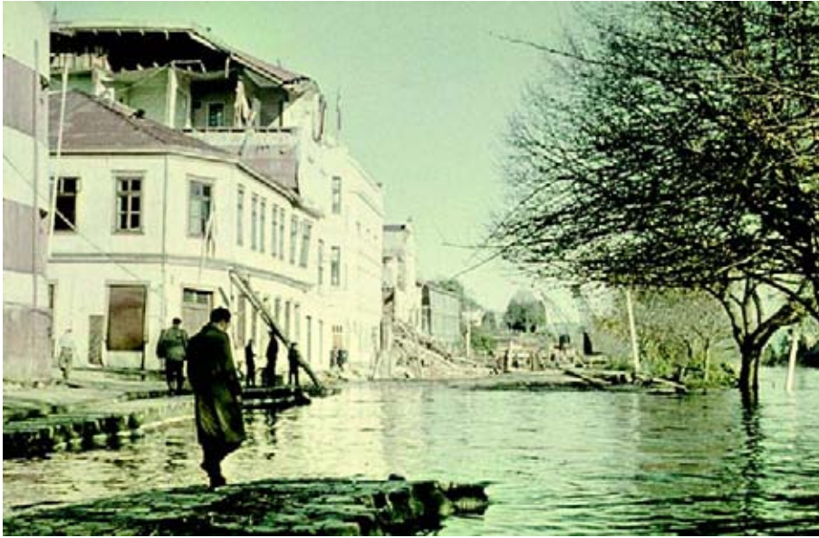
Figura 58. Efectos destructivos del tsunami en Valdivia.
