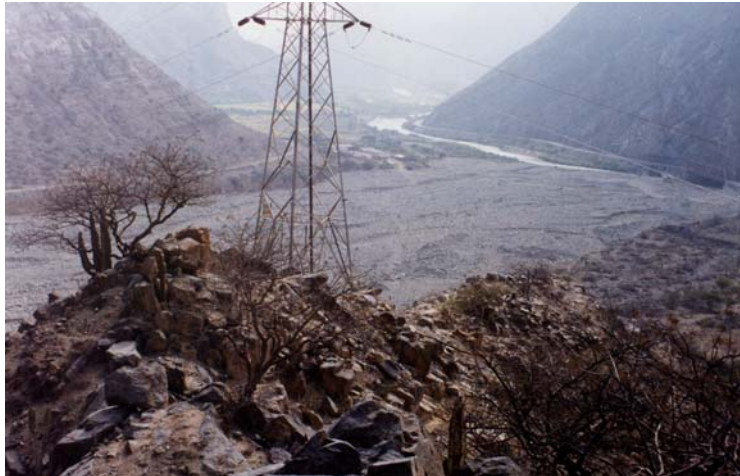
Figura 1. Vista panorámica hacia el noroeste desde la más alta estación de Yonán, que aparece en primer plano. Al centro está el pueblo de Yonán, pasando la Quebrada de Shausís. El río Jequetepeque corre de derecha a izquierda, hacia el oeste.
