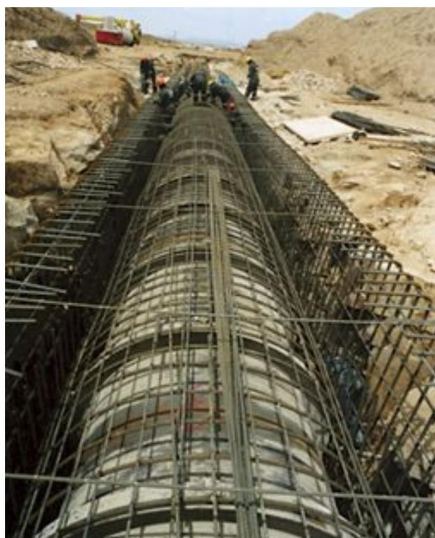
*Tubería de descarga de la Presa*
