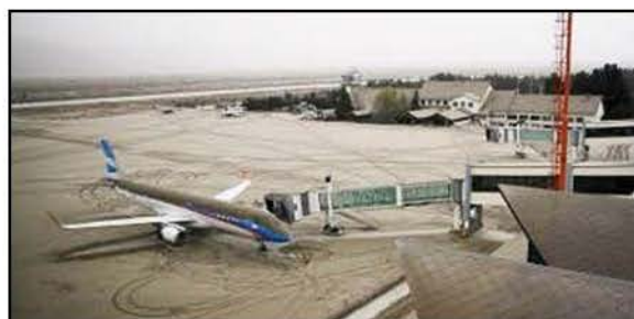
Fig. 2 – Aeropuerto de la ciudad de San Carlos de Bariloche, que permaneció cerrado durante varios meses como consecuencia de la erupción del Cordón Caulle del 4 de junio de 2011.
