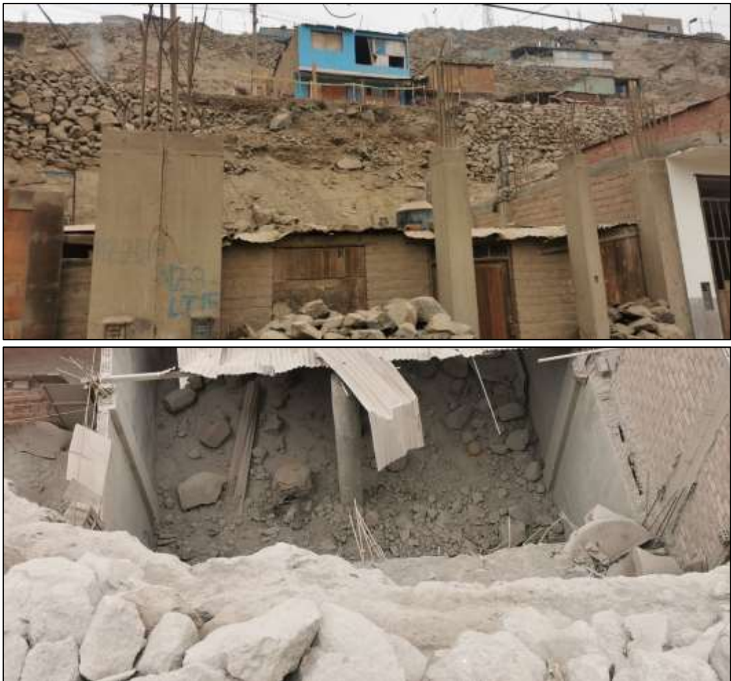
Ilustración N° 8 Derrumbe en la calle Las Orquídeas y alcance de los bloques caídos
