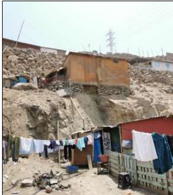
Ilustración N° 7 Caída de rocas de una pirca
