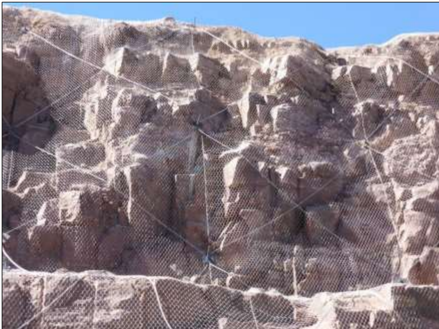
Ilustración N° 13 Malla anclada para talud fracturado
