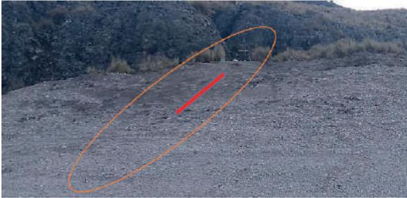
Foto 5: Reducción de carga del material, perfilado del talud del Pad e implementación de Extensómetros Mecánicos (Utunsa, enero 2019).
