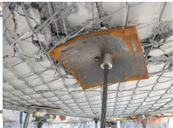
Fig. 8 Cable bolts a presión
