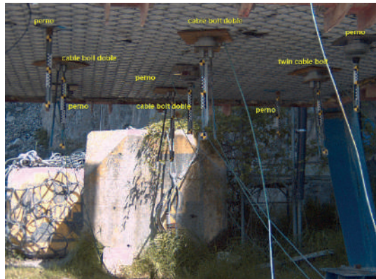
Fig. 3 Vista inferior configuración con MinaX® 65/4, cuatro cables bolts dobles y cinco pernos
