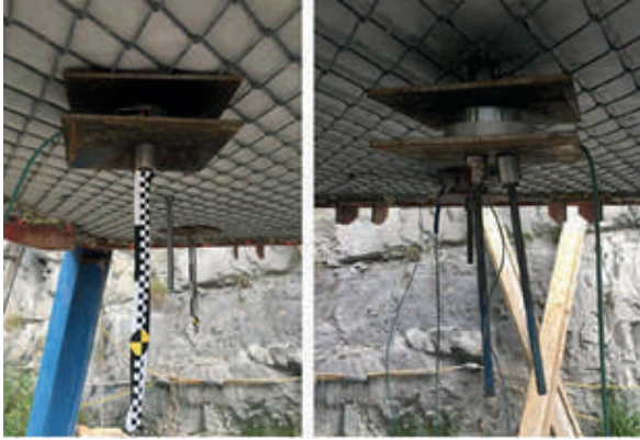
Fig. 5. Células de carga en los anclajes
