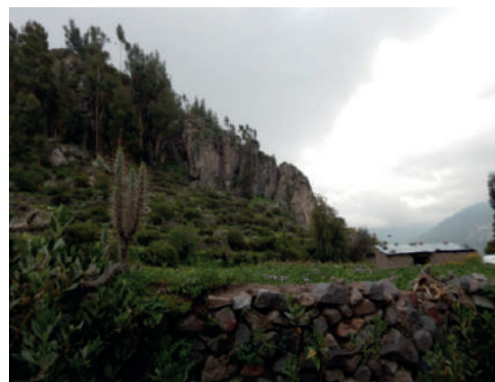
Foto 1. Peligro por tumbamiento ubicada al oeste de la zona urbana de Achoma
