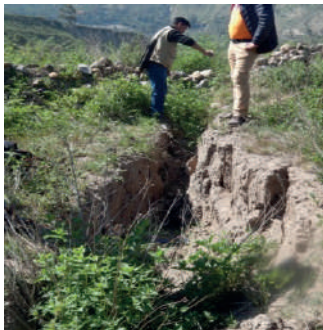
Foto 4. Grieta de gran tamaño en la zona de Tinina - Distrito de Ichupampa
