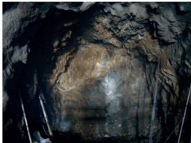
*Figura 12: Cuñas formadas durante la excavación.*
