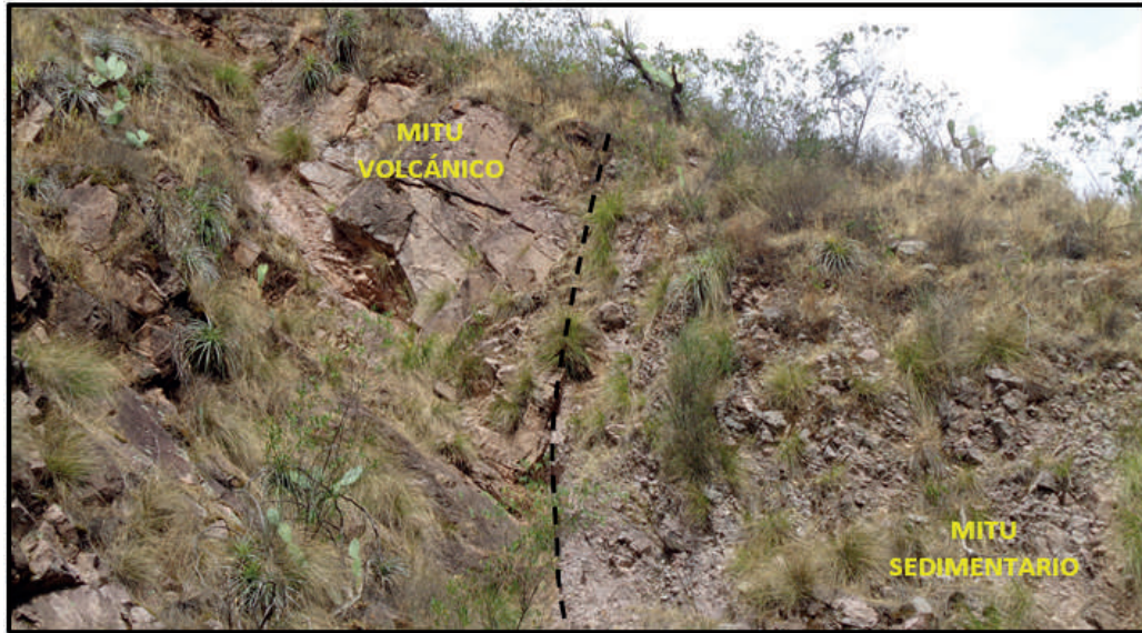
Figura 2. Contacto de falla entre las formaciones Mitu volcánico y Mitu sedimentario en la quebrada Puca Puca al SE del pueblo de Chaupis. Esta falla basculante presenta un rumbo de N 135° y buzamiento de alto ángulo variable debido al basculamiento hacia el SW.
