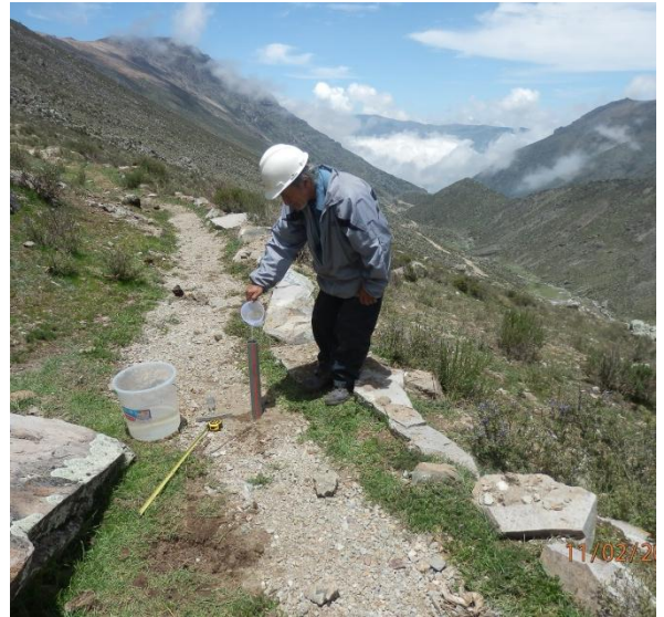
Fotografía 3. Antiguo canal colmatado, cuya restauración se adecuará para una de las Amunas en San Pedro de Casta.
