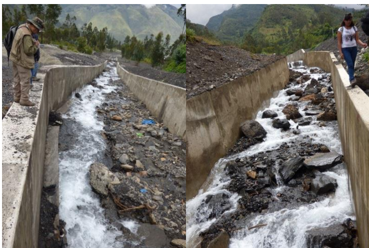
Fotos 1 y 2. Canalización de la quebrada Sahuanay construida en el 2014-2015 (vistas hacia aguas arriba y aguas abajo). Obsérvese como el agua viene erosionando las paredes (fotos: Fluquer Peña, 2015).
