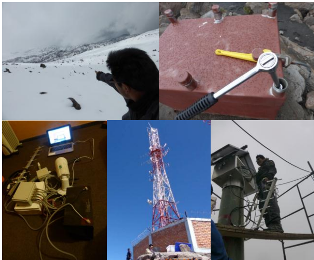
Figura 4. Implementación de la red telemétrica. Reconocimiento de campo en el volcán Sabancaya (Arriba izquierda). Caseta de seguridad para una estación sísmica en el volcán Sabancaya (arriba derecha). Pruebas antes de la instalación de una cámara de video (Abajo izquierda). Pruebas de transmisión en Chachani (Abajo medio). Vista de la construcción de la caseta del DOAS, y la instalación de la antena (Abajo derecha).
