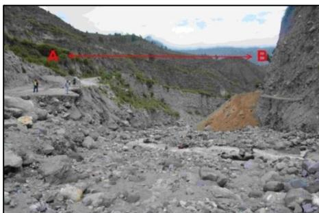
Figura 4.- El lahar arrasó con este tramo de camino, en las coordenadas 301 241E – 8 186 432N. La longitud de acceso dañado (A-B) fue de 30 metros.
