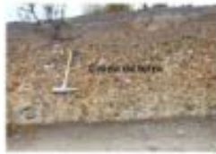
Figura 2b. Caída de cenizas en la parte oriental del edificio.
