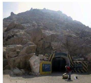
Figura 3. Bocamina de entrada de la mina modelo CENTROMIN PERÚ
