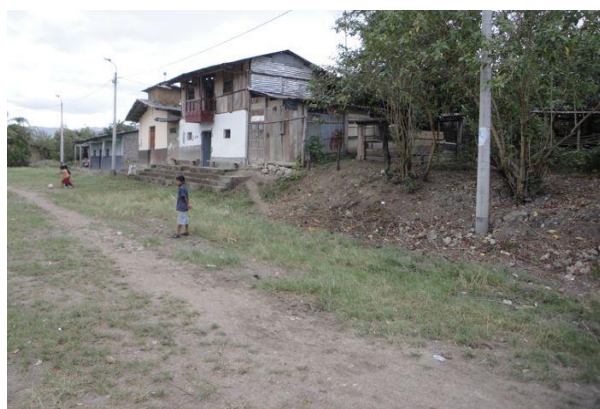
Foto 2. Viviendas afectadas por el movimiento del terreno, generado por el deslizamiento
