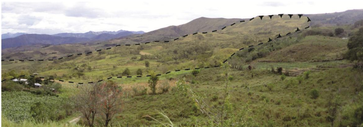
Foto 1. Vista panorámica del deslizamiento de Laguna Azul-Catahuas. Las líneas entrecortadas de color negro delimitan el cuerpo del deslizamiento.
