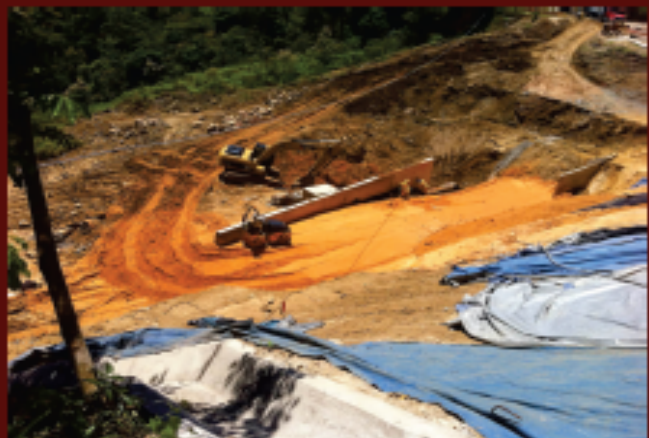
Fig. 3. Aplicación de los valores de la capacidad portante, construcción de Muro de Concreto Armado.
